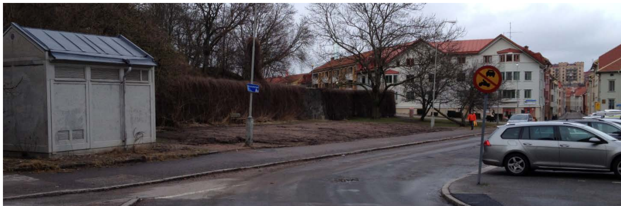
Foto 1. Teknikbyggnad samt stödmur mot väster och Skansberget
